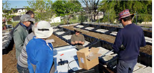
Chantier participatif à Quéven en mai 2023 © ALOEN
